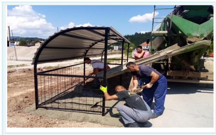
Фотографија 62: Уградња надстрешница за контејнере, извор: Предраг Клачар - Стручни рад „Еколошки прихватљиво управљање отпадом у општини Пале“
