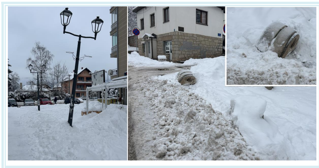
Фотографија 107: Улица Алексе Шантића (Шеталиште - приликом чишћења машином за чишћење, дошло је до оштећења стуба за расвјету), улица Романијска 15 (поред Општине - приликом чишћења коловоза снијег је нагрнут на пјешачку стазу и дошло је до оштећења и превртања саксије), извор: општина Пале
