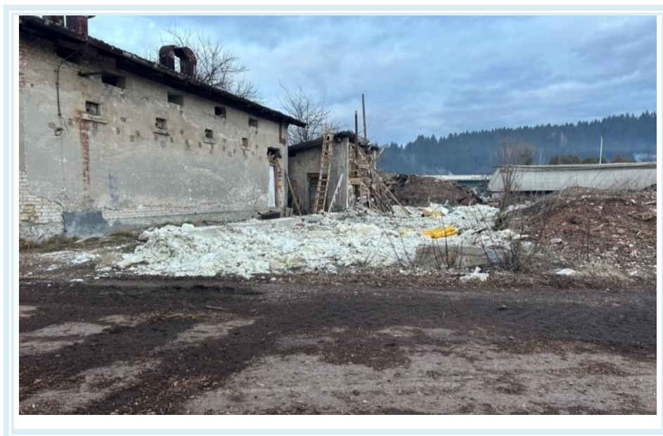
Фотографија 72: Рушење објекта у кругу топлане, отпад стаклена вуна, извор: Предраг Клачар - Стручни рад „Еколошки прихватљиво управљање отпадом у општини Пале“
