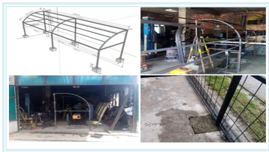
Фотографија 60: Израда и уградња надстрешница за контејнере, извор: извор: Предраг Клачар - Стручни рад „Еколошки прихватљиво управљање отпадом у општини Пале“
