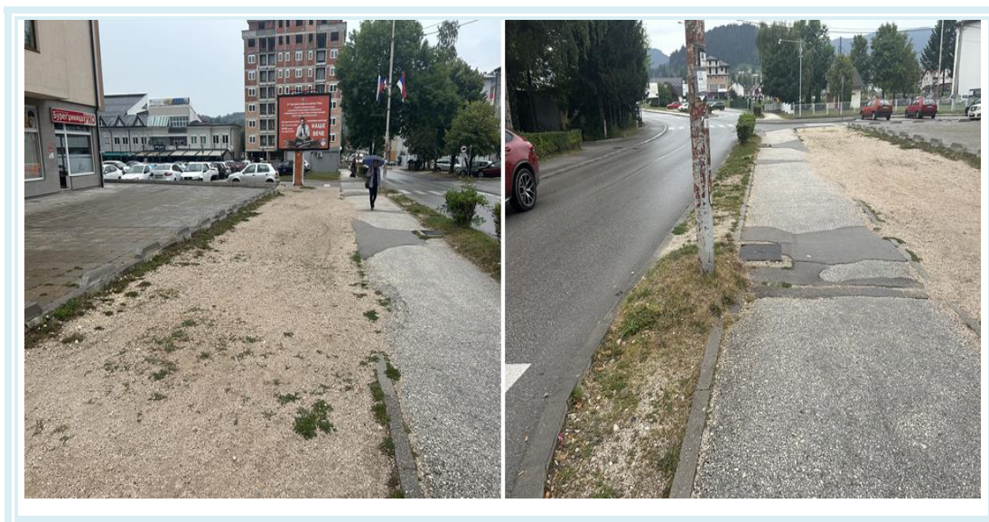
Фотографија 104: Улица Милана Симовића, извор: општина Пале - Због близине ОШ Пале потребно је уредити простор - пјешачку стазу, постављањем бетонских саксија би се створила јасна граница, саксије морају бити довољно тешке и стабилне како би се осигурало да остану на мјесту и не представљају ризик пролазницима.
