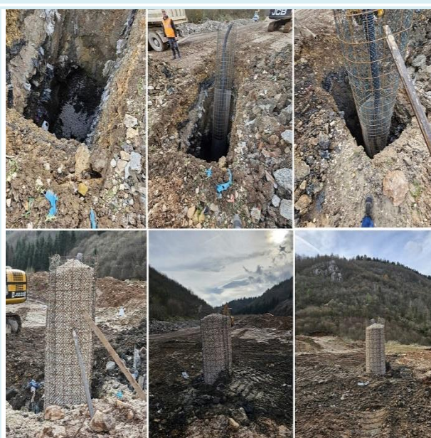
Фотографија 83: Уградња отплињивача, извор: Ј.П. „Комунално А.Д. Пале
